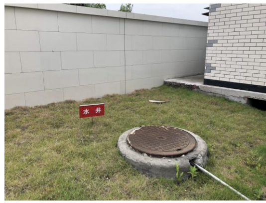
站内地下水井
