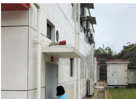
发电机排气筒
