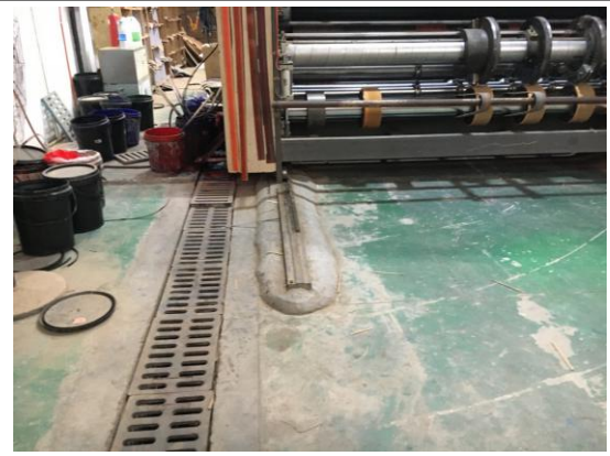
厂内清洗废水收集沟
